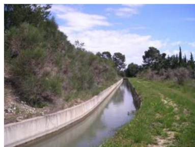
Canal maitre à ciel ouvert bétonné
